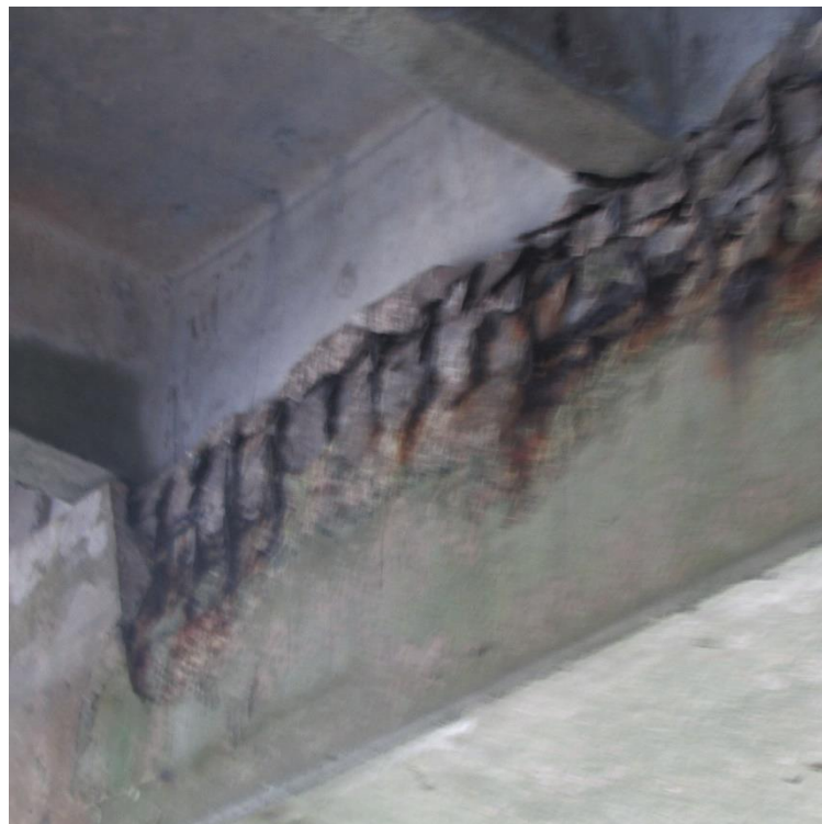
Foto 8 – Detalhe das armaduras expostas nas travessas – Píer
