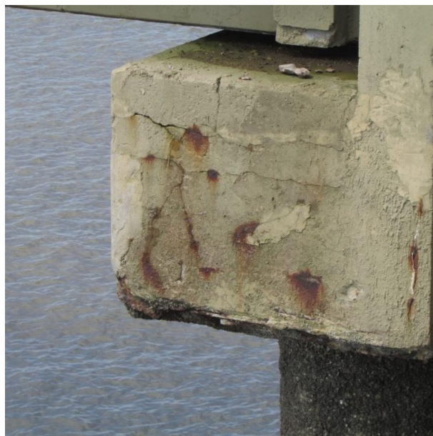
Figura 7 – Travessa: necessidade de recuperação nas bordas. Observa-se cracas nas estacas e nas regiões inferiores das travessa.
