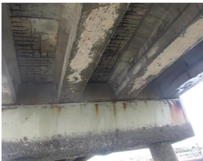
Foto 1 – Vista inferior do tabuleiro – Ponte de Acesso – Lajes com armaduras expostas
