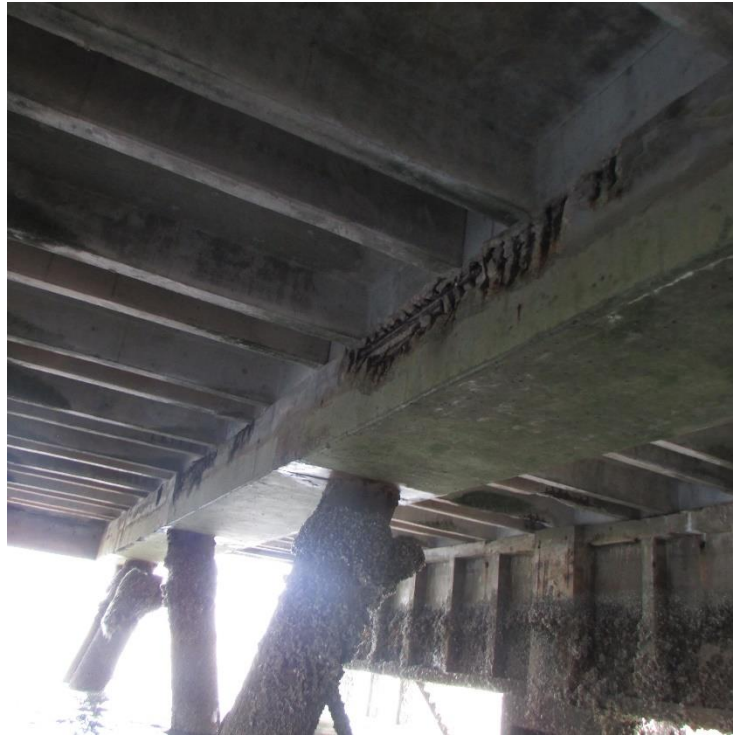
Foto 7 – Vista inferior das lajes PI, travessa com armadura exposta e cracas nas paredes – Pier
