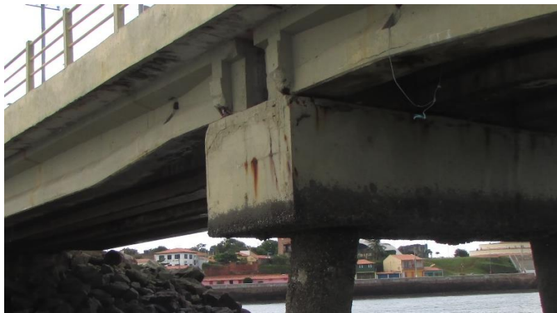
Foto 3 – Vista lateral da travessa de apoio – Ponte de Acesso – Oxidação nas faces
