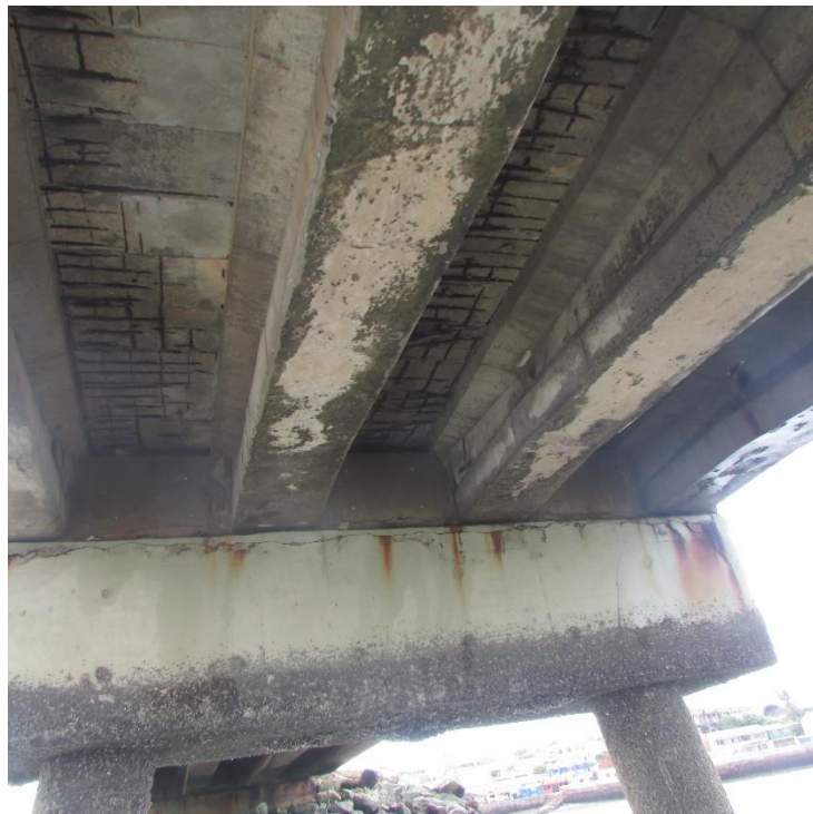
Figura 4 – Vista inferior do tabuleiro – Ponte de Acesso – Lajes com armaduras expostas.
