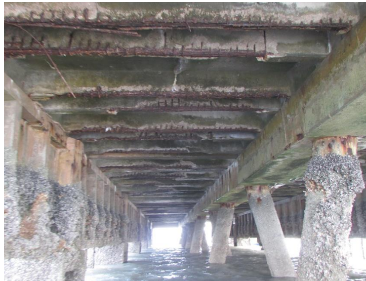
Foto 4 – Vista inferior da estrutura do Píer – lajes PI com armadura exposta, travessas e estacas com cracas
