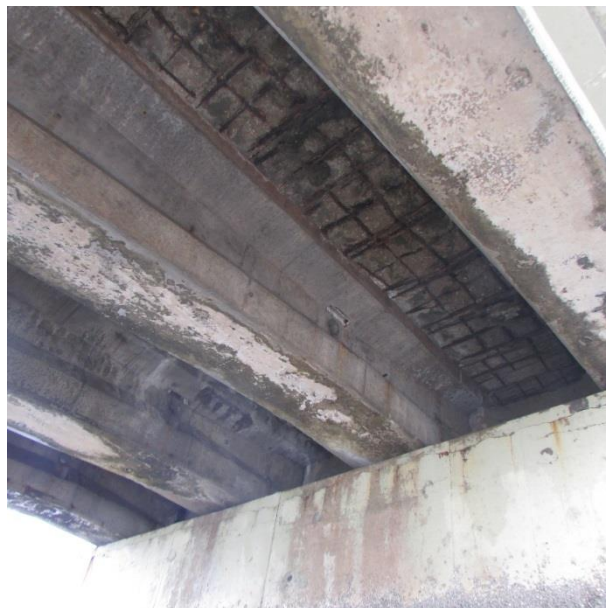
Figura 6 – Vista inferior do tabuleiro sem anomalias de destaque nas longarinas.
