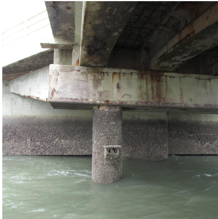
Foto 11 – Cracas nas estacas da Ponte de Acesso
