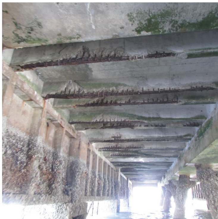
Foto 6 – Vista inferior das lajes PI – Píer - estado de deterioração das peças
