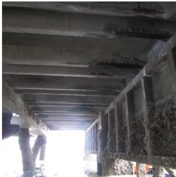
Figura 8 – Vista inferior da estrutura do píer, com elevado grau de deterioração da estrutura. Barras oxidadas, seccionadas e concreto disgregado.
