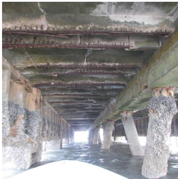
Figura 9 – Vista inferior da estrutura do píer, muito deteriorada. Cracas nas estacas e nas regiões inferiores da estrutura.
