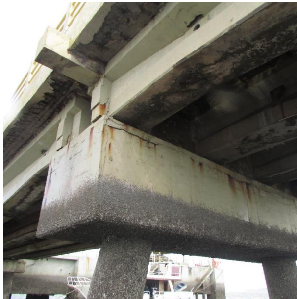
Figura 5 – Vista inferior do tabuleiro – Ponte de Acesso – Lajes com armaduras expostas E algumas anomalias menores (concreto disgregado) nas travessas; poucas anomalias nas longarinas.
