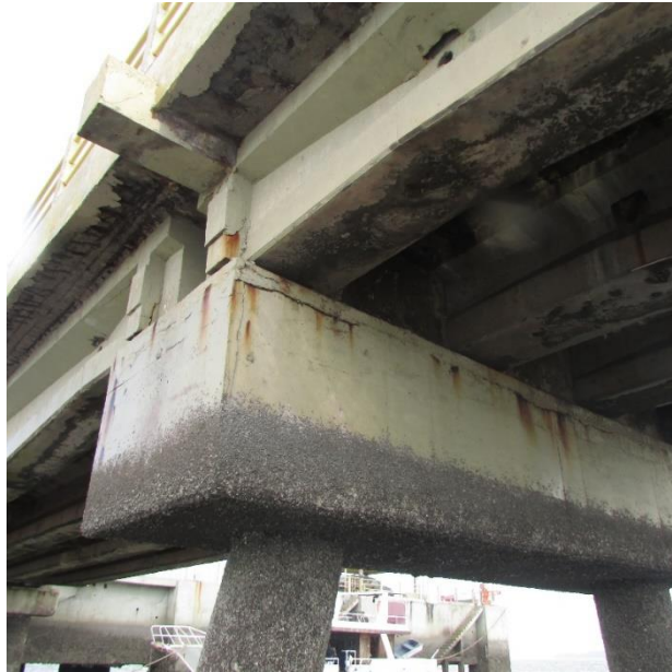
Foto 2 – Vista inferior do tabuleiro e travessa de apoio – Ponte de Acesso – Sem anomalias de destaque nas longarinas. Travessa: necessidade de recuperação nas bordas. Cracas nas estacas e travessa
