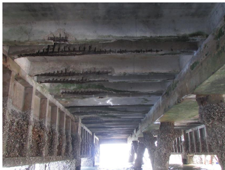
Foto 5 – Vista inferior da estrutura do Píer – lajes PI com armadura exposta, estacas e paredes laterais com cracas
