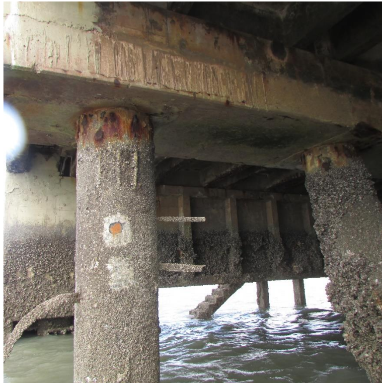
Foto 10 – Detalhes dos tops das estacas e faces internas das paredes do Píer – Cracas (Incrustações) nas superfícies
