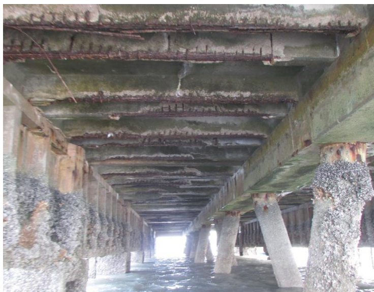
Foto 4 – Vista inferior da estrutura do Pier – lajes PI com armadura exposta, travessas e estacas com cracas
