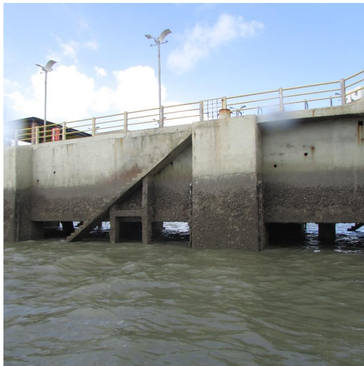
Foto 9 – Laterais das paredes e escadas do Píer – Cracas nas superfícies
